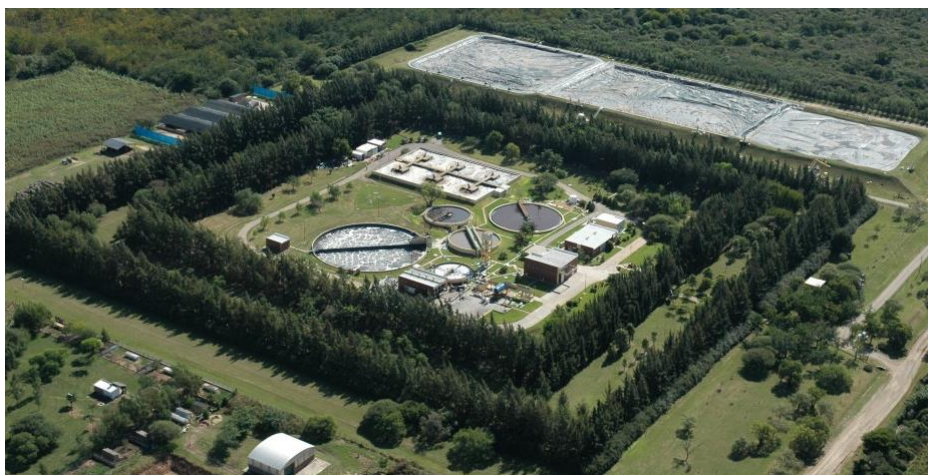
Figura Nº 45: Planta de tratamientos de efluentes. Consorcio para la preservación de la ecología S.A. Esperanza. Santa Fe.
