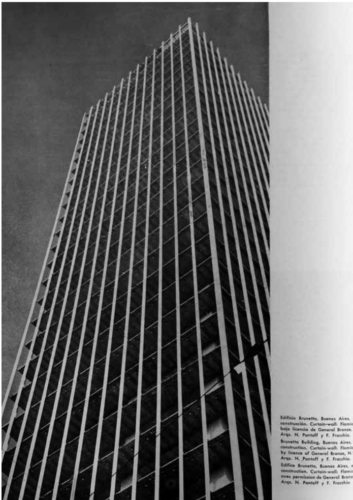
Figura 03. Montantes de aluminio en el curtain wall de la torre Brunetta. Summa (3:68)
