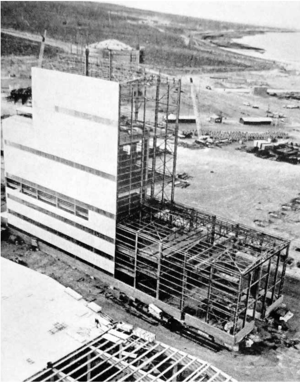
Figura 01. Planta ALUAR: vista construcción edificio de molienda. Fuente: Summa (91–92), 55, julio–agosto de 1975
