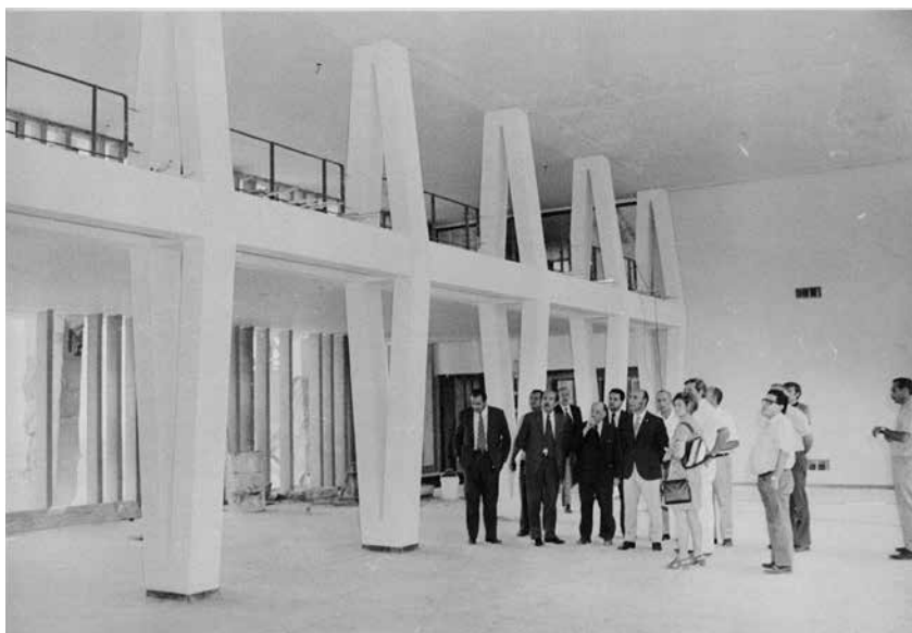
Figura 07. Fotografías del edificio de la Facultad de Filosofía y Letras. Fuente: CDH UNCuyo.
