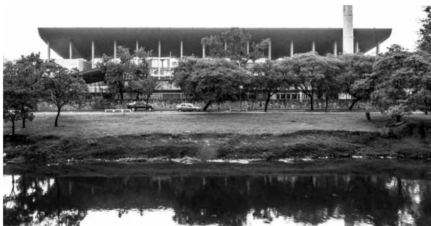
Figura 01. Fachada norte sobre el río Suquía. Fotografía: Gonzalo Viramonte (2013).
