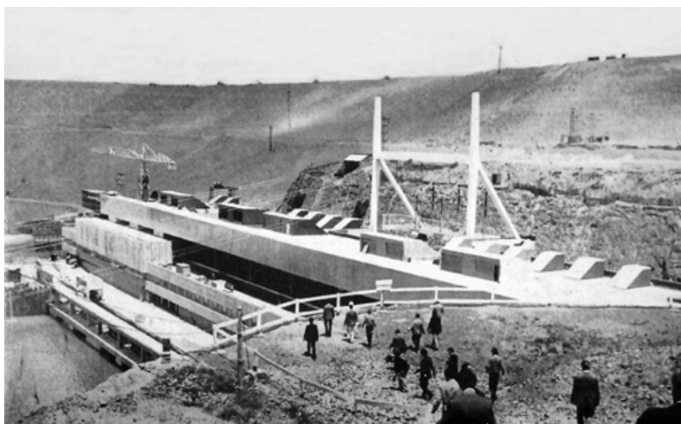
Figura 02. Complejo Hidroeléctrico Chocón–Cerros Colorados. 1968.
