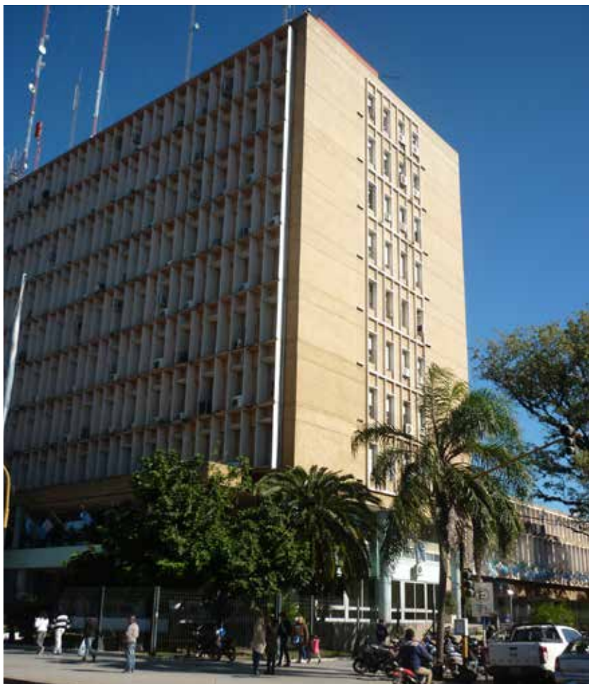
Figura 14. O. Stortini. Casa de Gobierno de Chaco. Resistencia. Provincia de Chaco. 1955. Foto: Cecilia Parera (2015).
