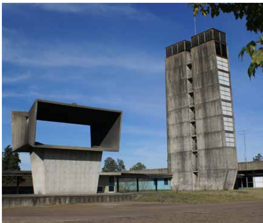
Figura 08. M. R. Álvarez. Ventilaciones. Túnel Subfluvial Santa Fe – Paraná. Foto: Luis Müller.
