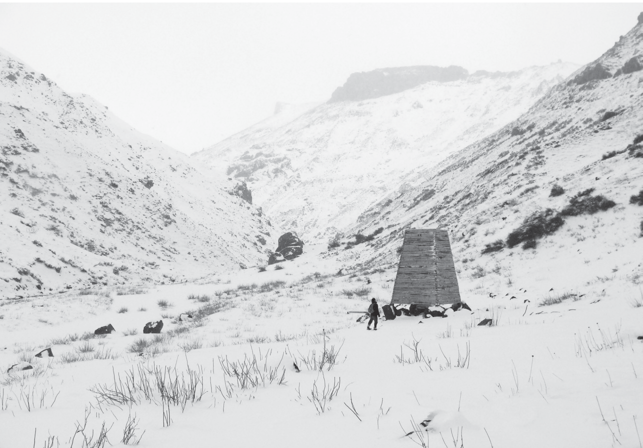
Imagen 9. Obra: Refugio La Sombra. Proyecto y ejecución: Estudiante de la Escuela de Arquitectura de la Universidad de Talca: Edgard Alfredo Torres Torres. Profesor guía: Arq. Germán Valenzuela Buccolini. Ubicación: Cordillera de los Andes, Chile. Año: 2007. Fotografía: Edgard Torres Torres.
