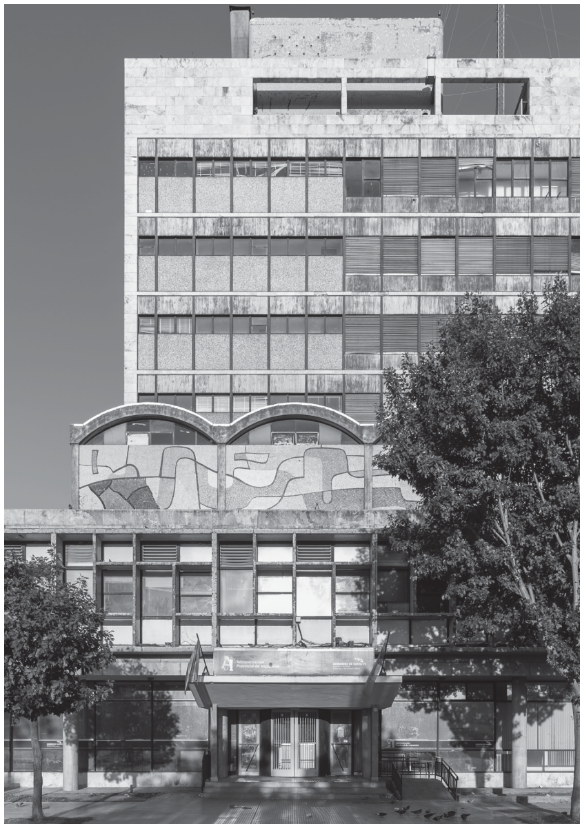
Imagen 14. Obra: Palacio de Correos de Santa Fe. Proyecto: Arqs. José María Spencer y Walter Finkbeiner. Ubicación: Santa Fe, Argentina. Años: 1954–1959. Fotografía: Ramiro Sosa.
