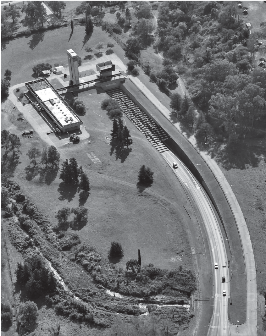
Imagen 12. Obra: Túnel Subfluvial Raúl Uranga–Carlos Sylvestre Begnis. Proyecto: Arq. Mario Roberto Álvarez. Ubicación: Santa Fe–Paraná, Argentina. Años: 1961–1969. Fotografía: Rubén Cabrera.
