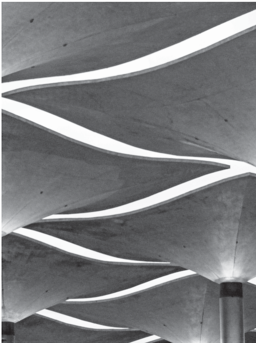
Imagen 15. Obra: Bóvedas cáscaras. El Molino. Fábrica Cultural. Proyecto: Arq. Amancio Williams. Ubicación: Santa Fe, Argentina. Año: 2010. Fotografía: Luis Müller.
