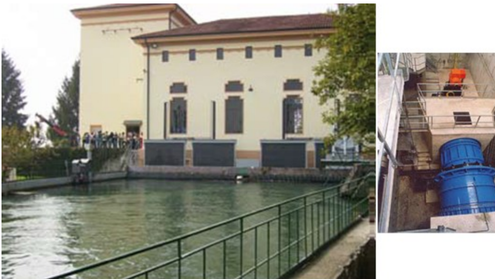
Figura 6.6. Sitio San Lázaro. Central hidroeléctrica de 1° salto (izq.) y Central hidroeléctrica, detalle (der.)
