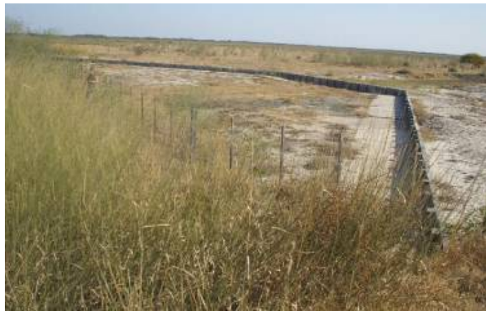
Figura 6.10. Ejemplo de medida de regulación: Vertedero de la Laguna del Dentado (Foto: INA-MIyT, 2018)
