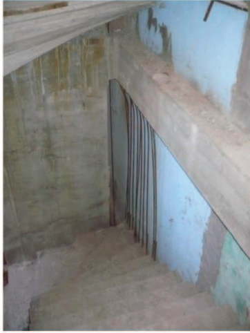
Escalera de ingreso principal a las unidades y oficinas.
