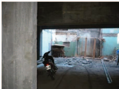
Vista hacia el fondo del edificio, donde se ubicarán las cocheras.
