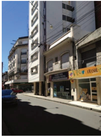
Se observa el edificio desde calle 25 de Mayo.
