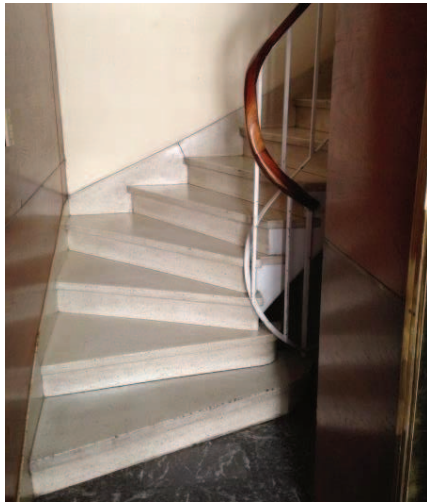
Escalera de ingreso principal a las unidades.
