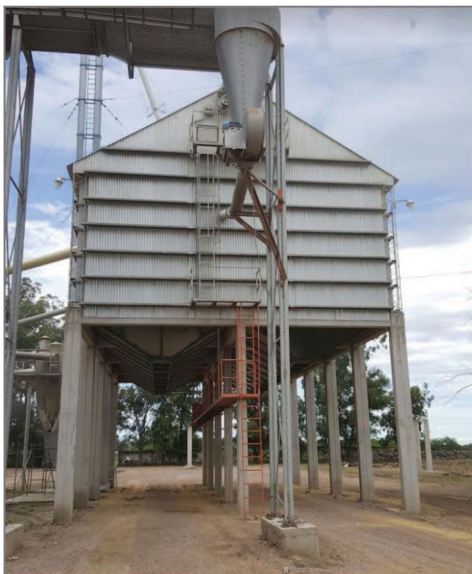
Figura 6. Silo de chapara aéreo. Vista de frente Fuente: Propia
