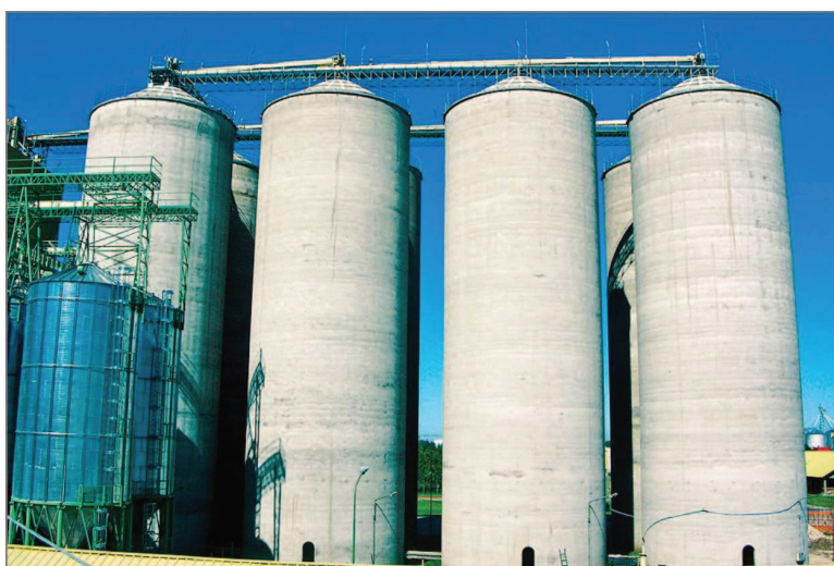
Figura 2. Silos de hormigón
