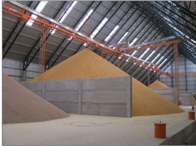
Figura 4. Silo celda por dentro
