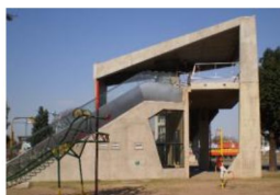
31. Acceso pasarela Foto: PIC
