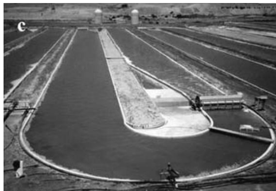
Figura 6.1: Fotografía de un open pond utilizado para la producción masiva de Dunaliella en el Nature Beta Technologies Ltd (Eilat, Israel)
