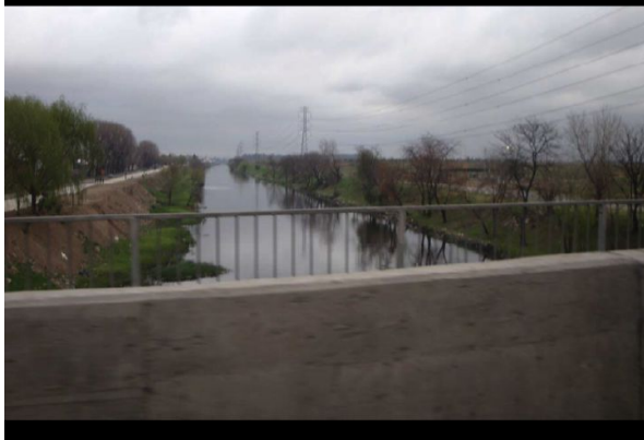
VISTA ACTUAL DEL SECTOR RECTIFICADO DEL RÍO MATANZA-RIACHUELO (PUENTE LA NORIA).
