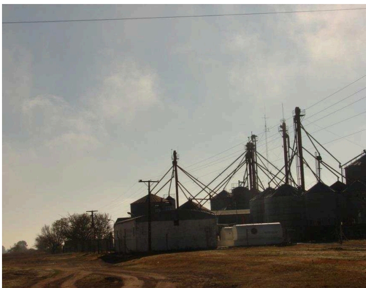
Foto 6. Planta de silos para granos en zona eminentemente ganadera de carne, localidad de La Pelada.
